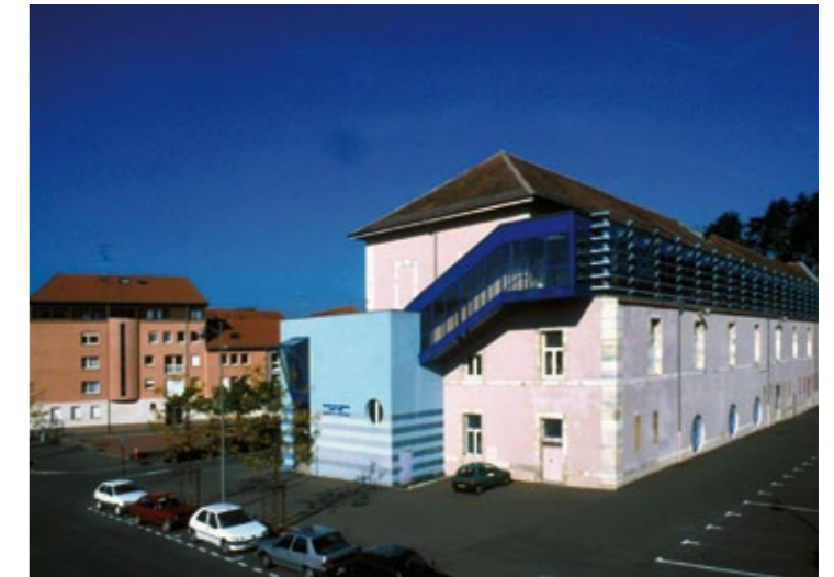
82 | Les anciens bâtiments des subsistances accueillant la faculté des sciences, ADTB 1552 W 785
