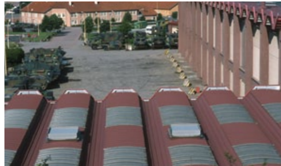
84 | La caserne de Maud'huy reconstruite en 1990, ADTB 1552 W 159
